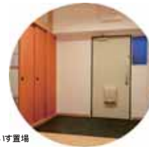
玄関の車いす置場
