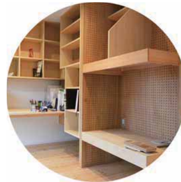
有孔ラワン合板の間仕切り壁
