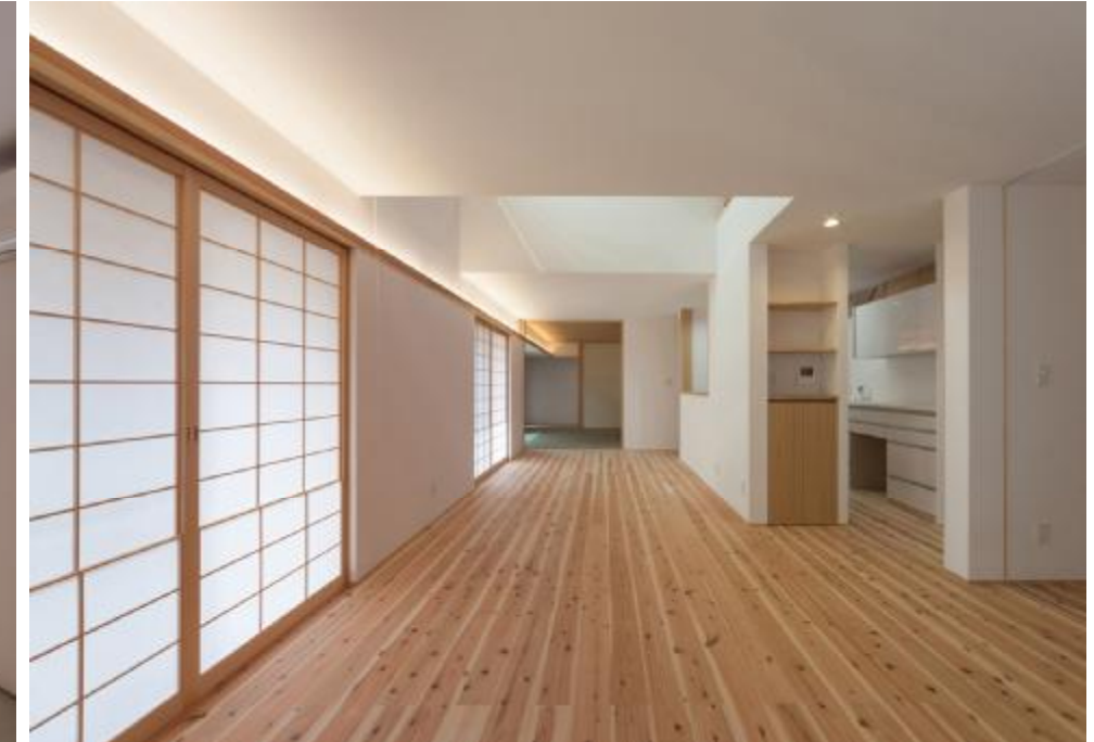
C 居間から和室を見る 雪見障子は壁内に引き込むことができる
